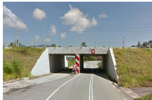
Contoh underpass bagi kegunaan orang awam
