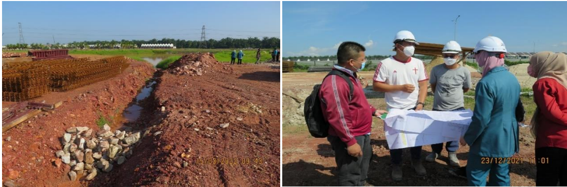
JAS Pulau Pinang melaksanakan operasi bersepadu dengan Jabatan Pengairan dan Saliran (Ops Lumpur) bagi aktiviti pembangunan perumahan
